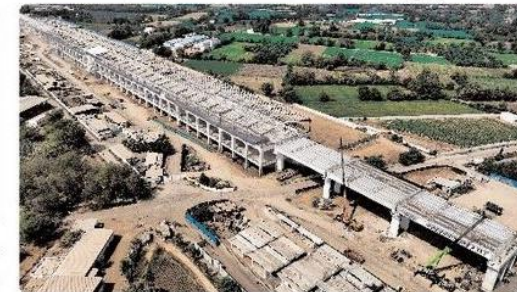
आणंद का निर्माणाधीन बुलेट ट्रेन स्टेशन।
